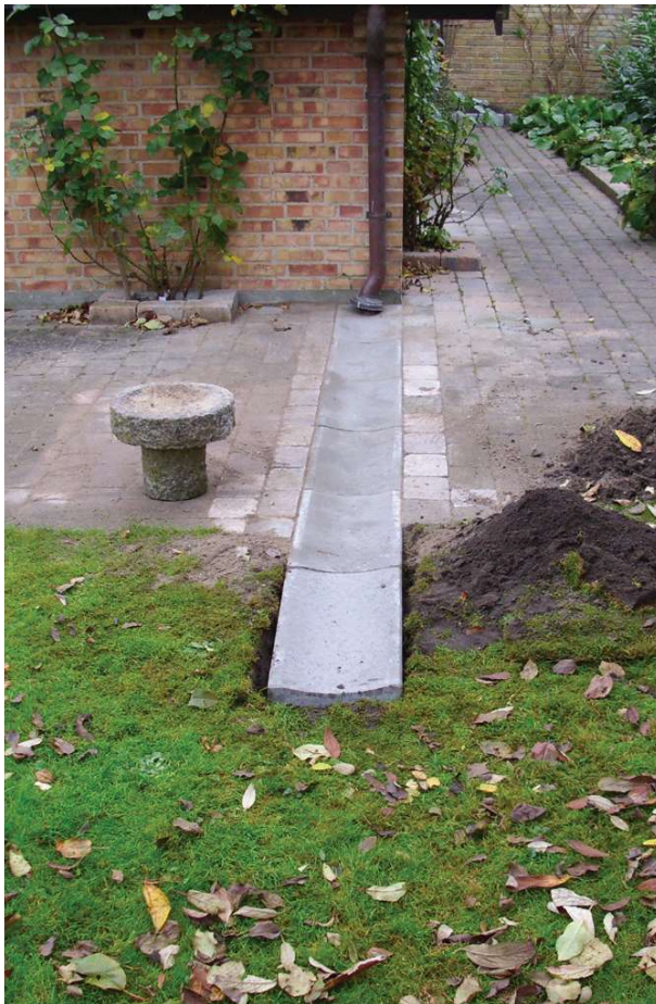
Figur 22: Eksempel på rende til at lede regnvand fra nedløbsrør og ud på græsplænen.
