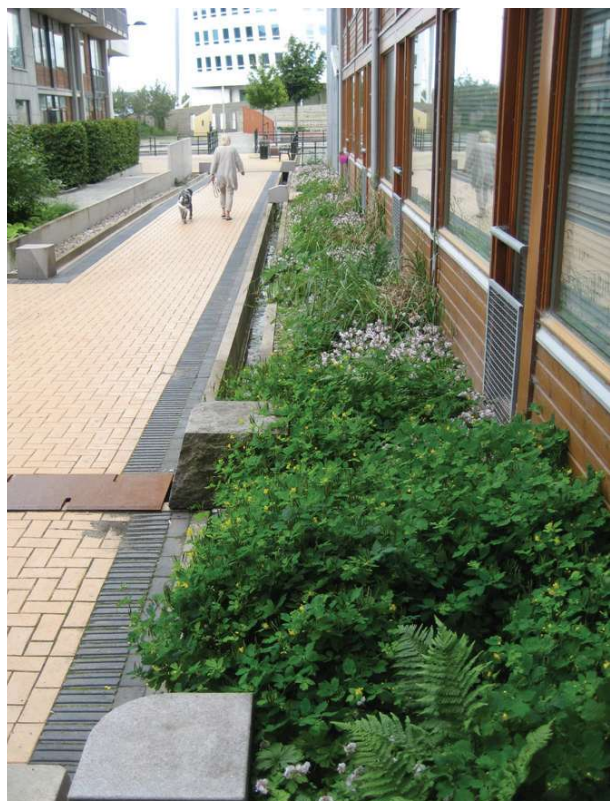
Figur 6: Beplantet regnbed, BO01, Västra Hamn, Malmø. Foto Orbicon
