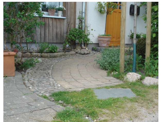
Figur 7: Afkoblet nedløbsrør ved rækkehusbebyggelse i Lübeck. Regnvandet ledes ud på græsplænen. Foto Orbicon.
