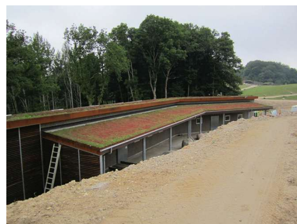
Figur 29: Sedumtag, Ree dyrepark. Foto Orbicon
