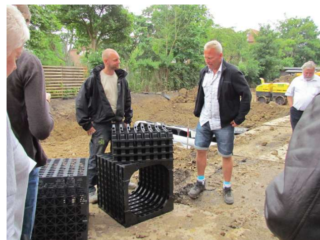
Figur 17: Faskinekassetter ved anlægsarbejde i Valby. Foto Orbicon
