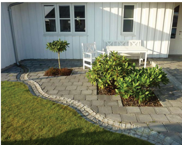
Figur 26: Regnvand ledes i en tæt rende bort fra huset til nedsivning i græsplænen. Foto Orbicon, Trekroner i Roskilde.
